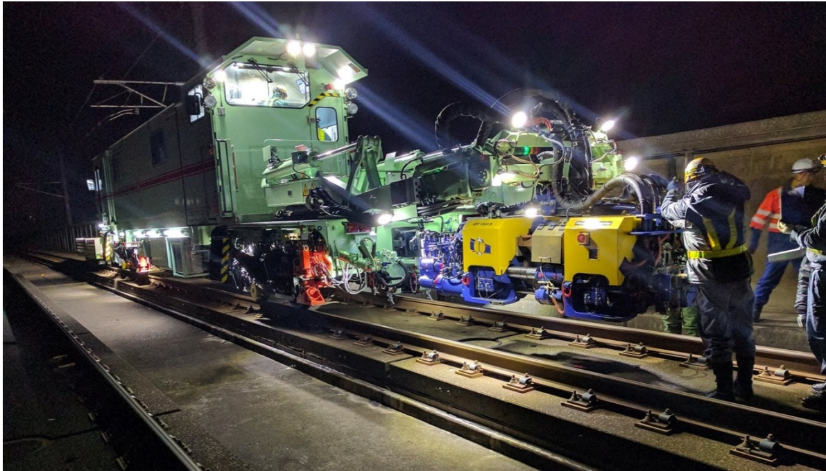
III. 11: Le robot de soudage APT mobile de Plasser & Theurer fait partie du système de remplacement de rails REX-S 1200 utilisé sur le réseau Shinkansen.
