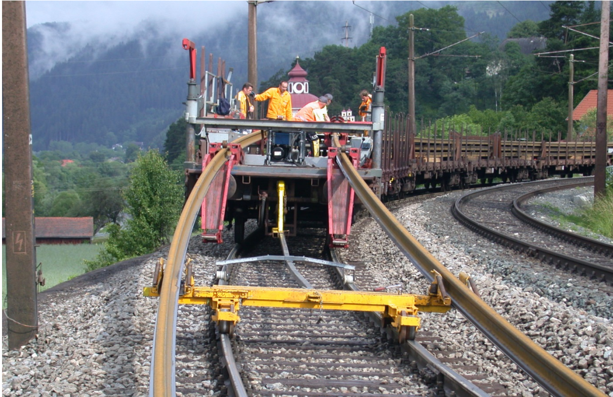
Ill. 5: Le 40.30 Rail Putler est l'alternative avantageuse sur le plan coûts au train de chargement de rails.
