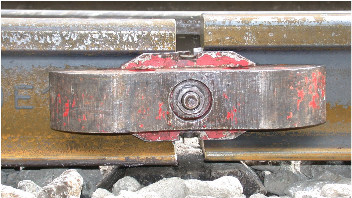
III. 6: L'utilisation d'éclisses permet le déchargement des rails dans le sens longitudinal sans endommagements.
