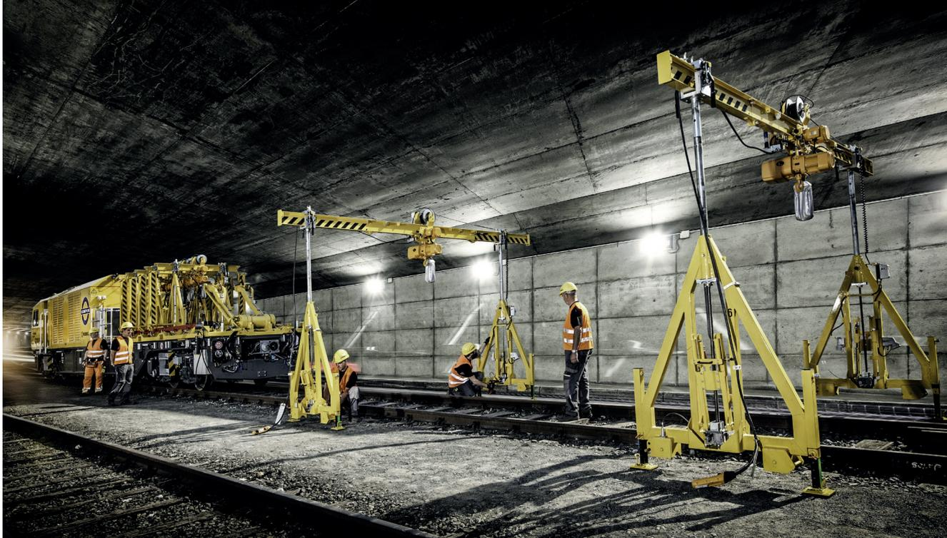
Bild 2. Ein modulares Auf/Abladesystem setzt Weichenumsetzportale im Tunnel platzsparend über die Pufferbrüst ab.
