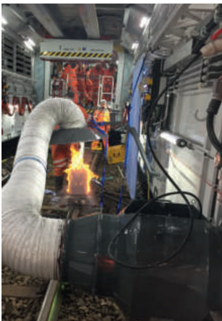
Abb. 4: Ein Hochleistungs-Absaugsystem hält den Innenraum der MIE bei Schweiß-, Schneide- und Schleifarbeiten emissionsfrei.
