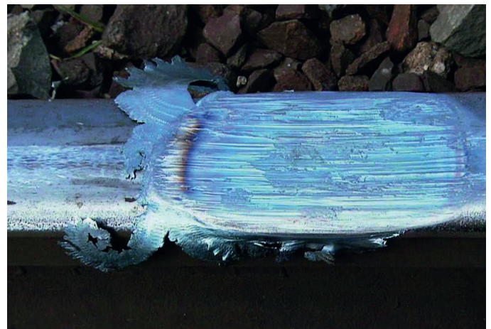
Abb. 1a/1b: Reparieren statt wegwerfen: Head Checks („schräg“) und tiefe Schleuderstellen, die üblicherweise einen Passschienenwechsel erfordern, lassen sich im automatisierten MSG-Schweißen wieder instandsetzen bzw. aufbauen und optimieren Quelle: SBB und Archiv Alfred Wöhhart aus dem Handbuch Eisenbahninfrastruktur
