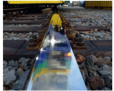
Abb. 8: Schienenoberfläche nach einer Überfahrt mit dem Schienenbearbeitungssystem
