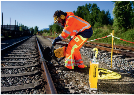
Abb. 6: Betrieben von einem 2300 Wh Akku, schafft das elektrische Schienentrennschleifgerät bei einer UIC60 Schiene bis zu 20 Schnitte.
