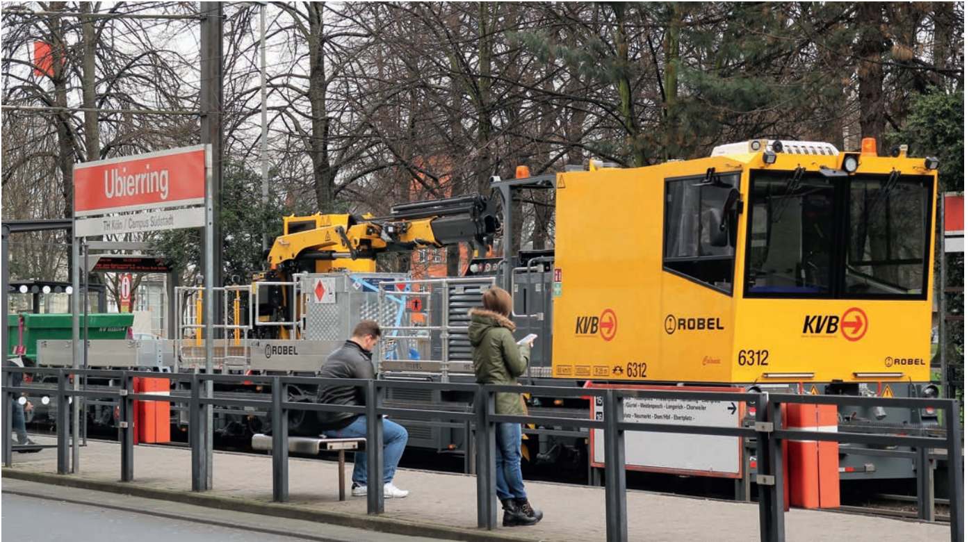
Abb. 4: Gleiskraftwagen 54.17 mit Ladekran im öffentlichen Straßenverkehr
