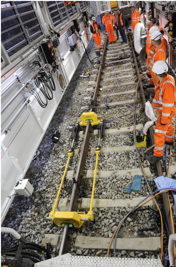
Abb. 7: Die Mobile Instandhaltungseinheit schafft einen geschützten, optimal ausgeleuchteten Arbeitsbereich für den Wechsel von bis zu 15-m-Passschienen mittels hydraulisch betriebener Maschinen.
