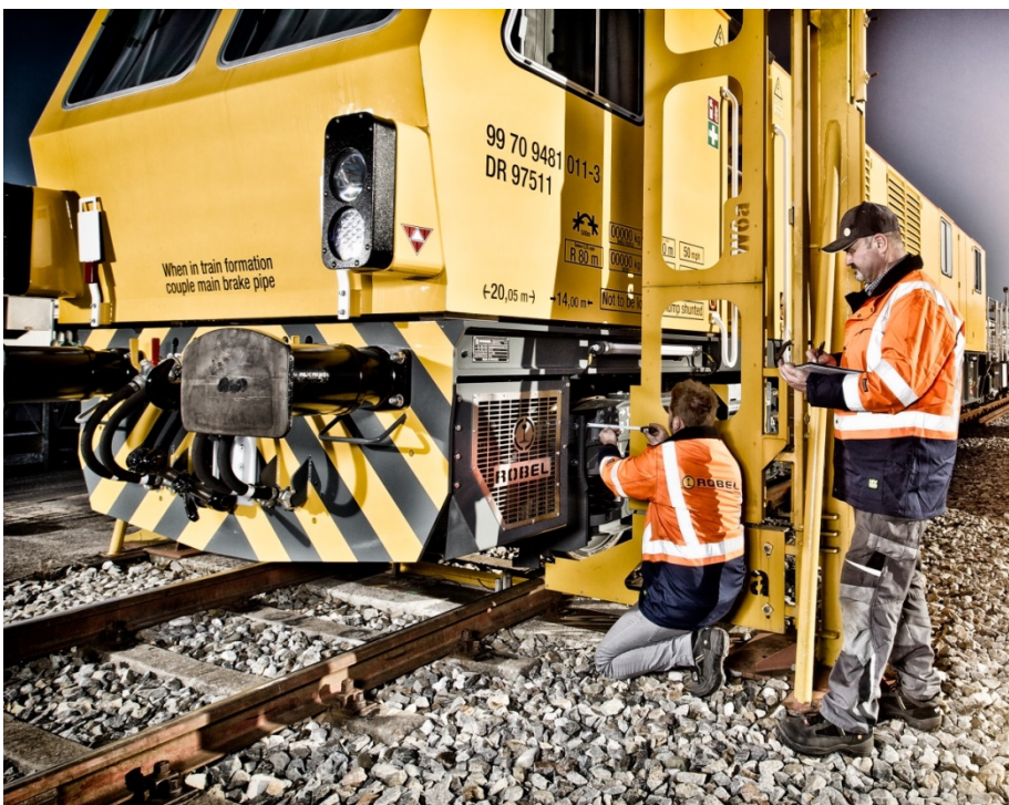
Ill. 5 : Mesure du gabarit sur la propre voie d'essais de l'usine
